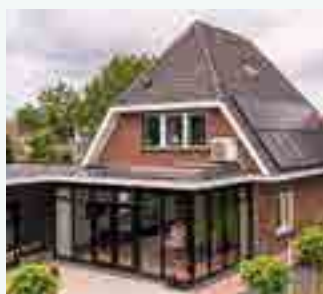
Aquarea T-CAP pruža potpuno rješenje za grijanje, hlađenje i potrošnu toplu vodu za adaptaciju luksuzne kuće u Voorthuizenu, Nizozemska. Aquarea
