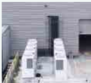
STEMCELL Technologies, globalno biotehnoško društvo, instaliralo je CO 2 kondenzacijske jedinice za hladne prostorije u skladištu. Francuska. Hlađenje
