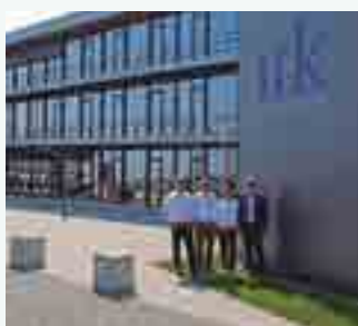
ITK Engineering GmbH. Inovativna poslovna zgrada koja se nalazi u Njemačkoj. ECOi - PACi
